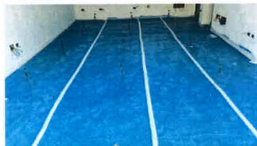
BARRIERA AL VAPORE PRE-GETTO DEL MASSETTO AUTOLIVELLANTE
