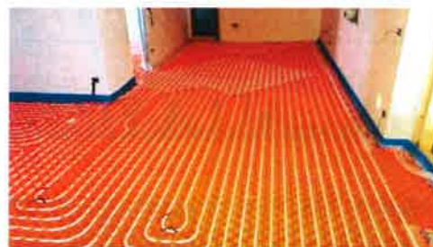
IMPIANTO A PAVIMENTO CON PANNELLO ISOLANTE
